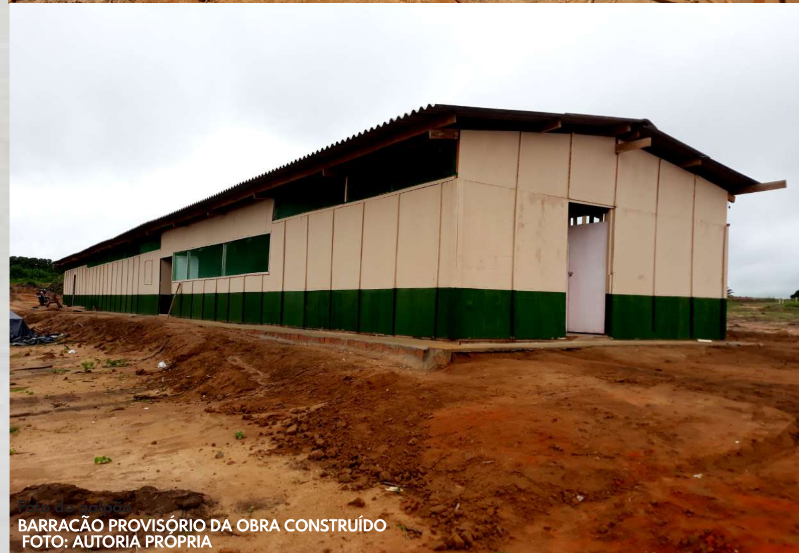
INÍCIO DA OBRA DO BARRACÃO FOTO: AUTORIA PRÓPRIA
