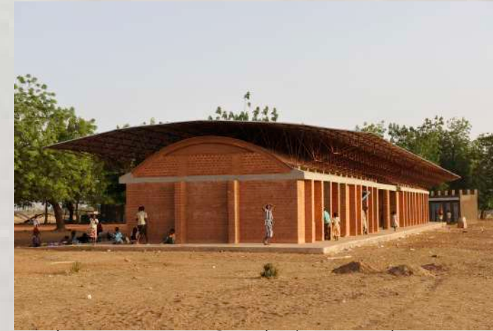
Escola Primária em Gando / Kéré Architecture, 2001
