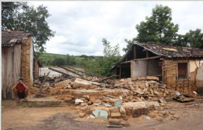
destruição de casas no Piquiá provocada por enchente em março de 2020 fonte: Associação Comunitária dos Moradores do Piquiá
